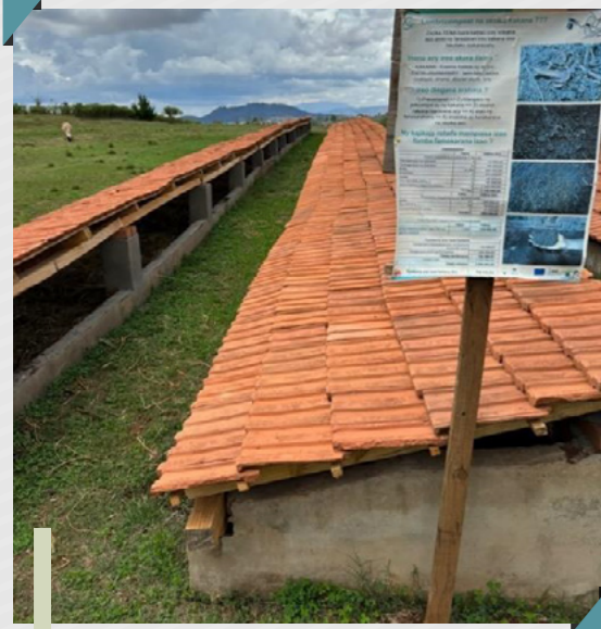
Lombricomposteur en béton du CEFFEL à Antsirabe protégé par une toiture en tuiles Toerana vita amin'ny simenitra an'ny Ceffel Antsirabe voaaro amin'ny tafo tanimanga
