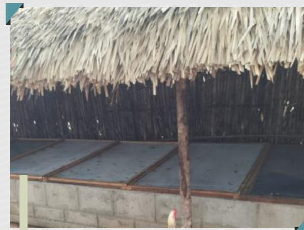
Lombricomposteur en béton sous ombrage en Satrana Toerana vita amin'ny simenitra mafy alokalofan'ny tafo satrana
